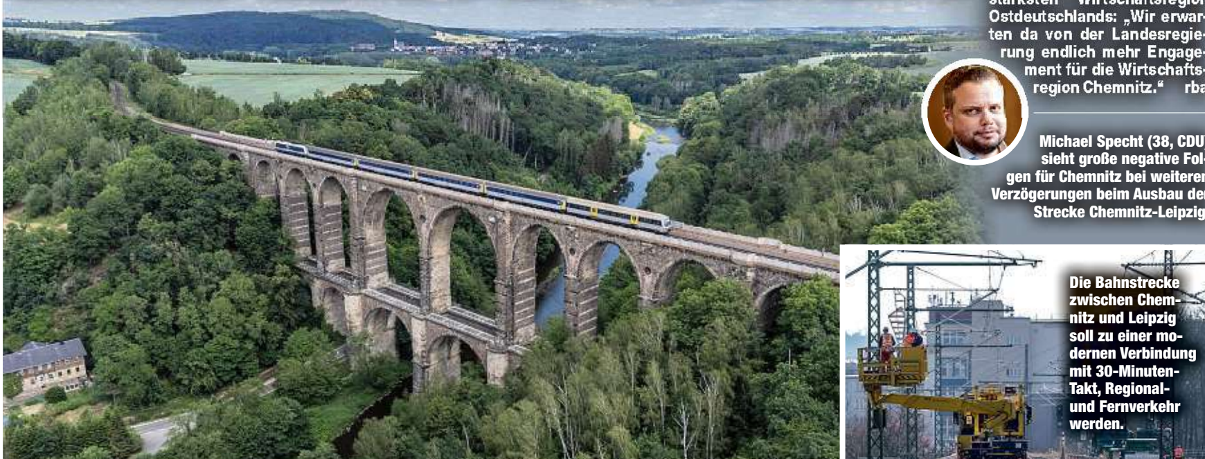
Das Göhrener Viadukt soll auch nach der Modernisierung der Bahnstrecke nach Leipzig eingleisig bleiben.
